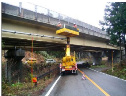
《橋梁の点検》北陸道 坂田川橋
