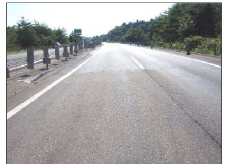
《路面のうねり、段差の復旧》 北陸道 長岡JCT～西山IC間
