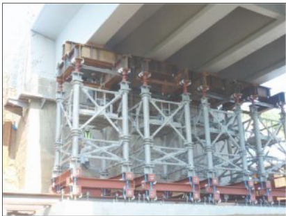
《主桁の断面修復》 北陸道 鉢崎橋
