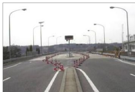
《矢本 IC 料金徴収設備撤去状況》
