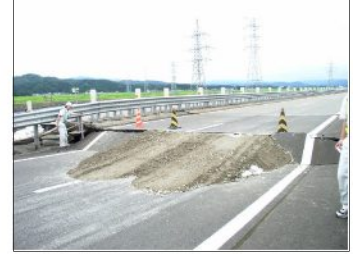
《路面段差の応急措置状況》
