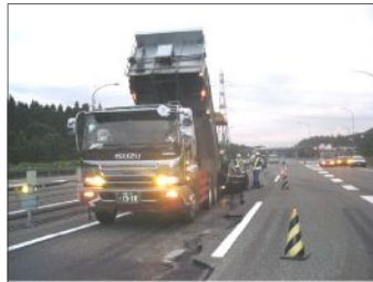
《路面段差の仮復旧作業》
