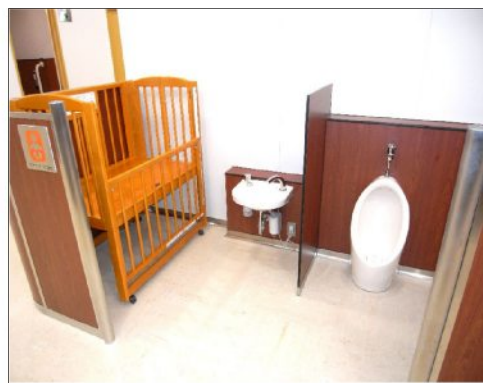
《子供用小便器・ベビーシートの設置》 関越道 三芳PA(下り)
