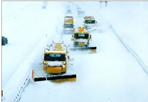
《除雪作業の状況》 道央道 旭川管内
