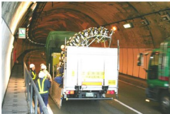
《計測状況》 長野道 一本松TN
