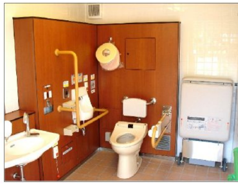
《多目的トイレ(身障者トイレ)内のベッド、幼児便座の整備》 東北道 黒磯PA(下り)
