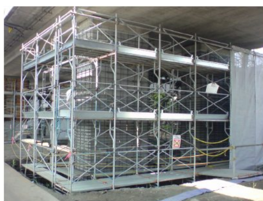
《施工状況》 道央道 大谷地高架橋
