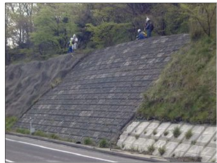
《のり面の点検》東北道 国見IC～白石IC間
