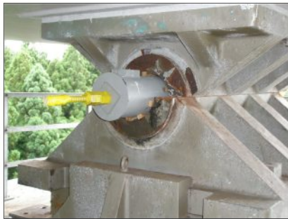
《支承の脱落防止》 北陸道 青梅川橋
