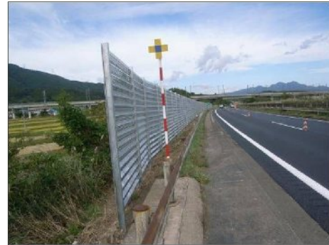
《防雪柵設置状況》 東北道 国見IC～白石IC間
