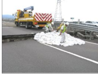
《路面段差の応急措置状況》
