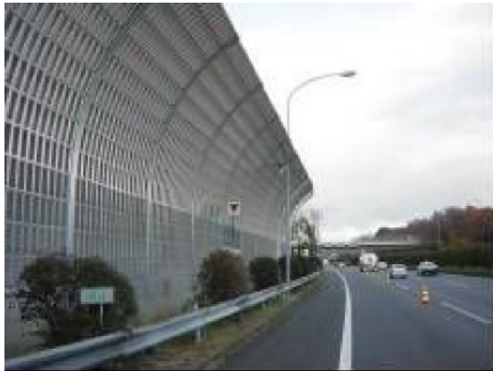
《遮音壁設置状況》
