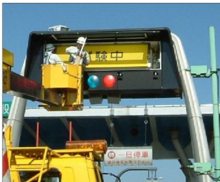
《ETC設備の点検》東北道 鹿沼IC
